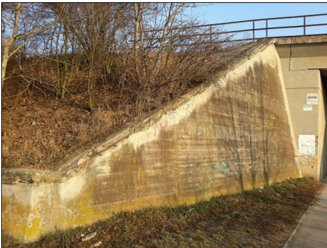
Obr. č. 14 - pohled na levé křídlo směr Jihlava s viditelným opadem betonu a korozí prutové výztuže
